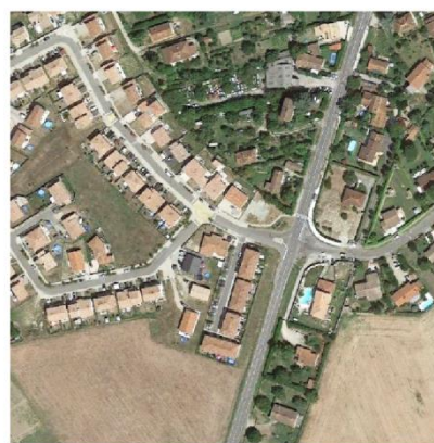
LES 2 EMPLACEMENTS RESERVES ONT ETE REALISES
